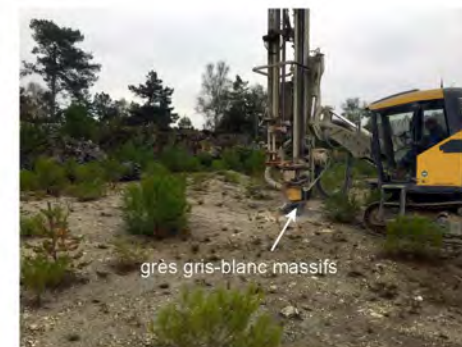
Fig. 3 : sondages de reconnaissance dans la carrière de Bellevue au droit des structures interprétées des panneaux électriques
